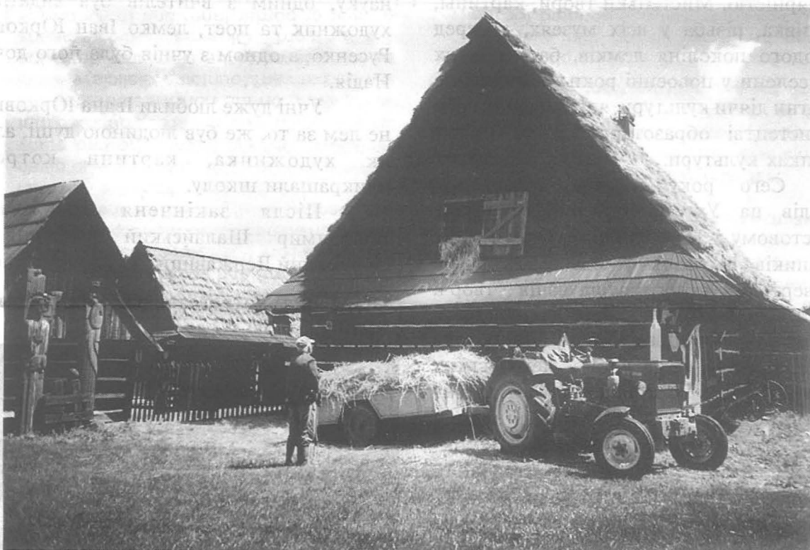
Нове покриття головної хижы кычкамы. Лемковина 2006 р. Фото Р.Гоч
